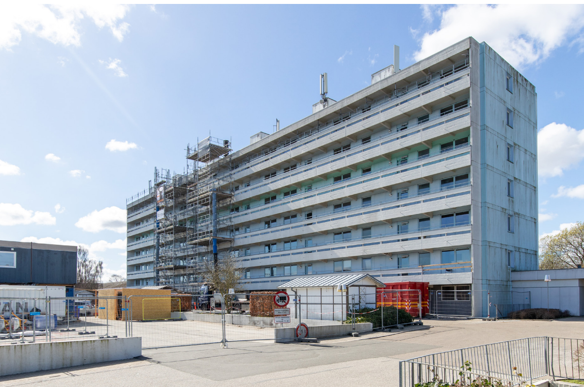
Beboere i Abildgades 79 boliger er alle genhuset, mens renoveringen står på.
