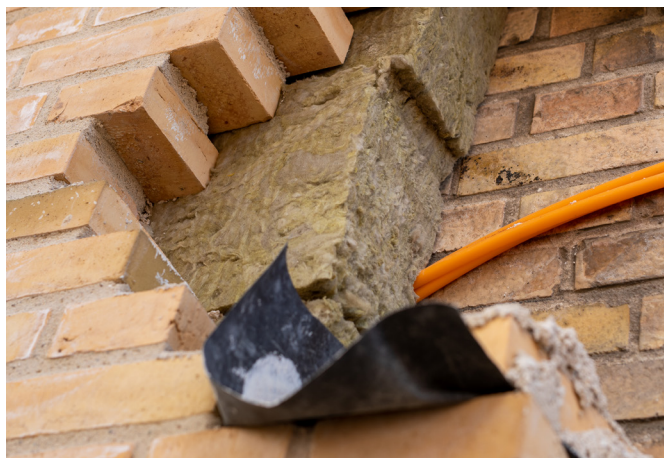
Ny overfrakke: Ovenpå den gamle ydermur ligger både et lag isolering og en ny række mursten.
