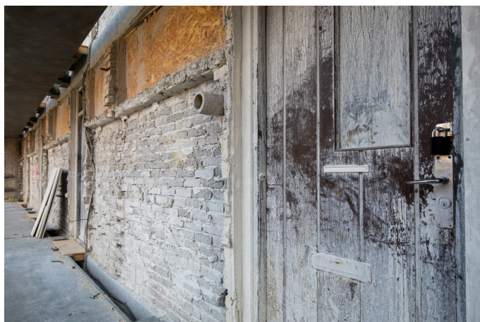
Alle beboerne i Altangangshuset er genhuset.
